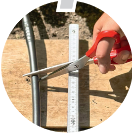
Schlauch nach Bedarf zuschneiden
